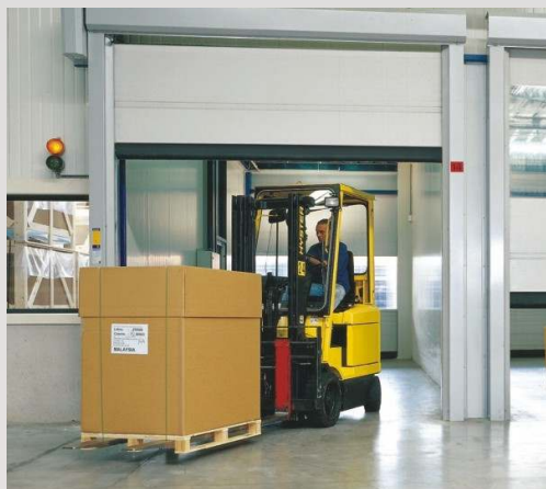
Industrial door activation
