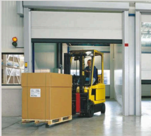
Industrial door activation
